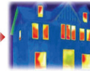
<단열재 설치 후>
