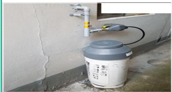
금속배관 및 용기차양 설치
