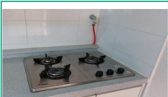
금속배관 및 퓨즈박스 설치
